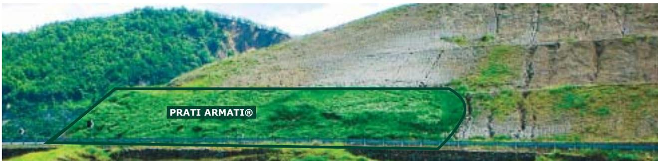
***Maggio 2006 - L'erosione completamente bloccata nella zona consolidata e rinverditata con i PRATI ARMATI®***
