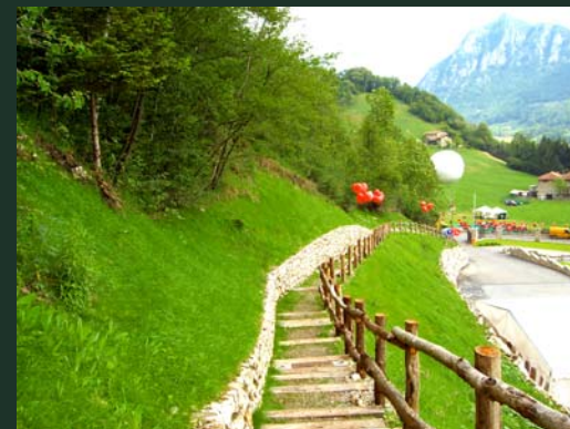
Il cantiere realizzato con i PRATI ARMATI® per lo stabilimento Mauri a Pasturo (LC)
