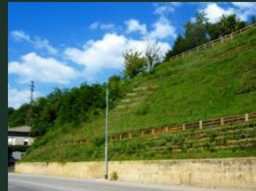
PRATI ARMATI® abbinati a palificate in castagno per il Comune di Lumezzane (BS)
