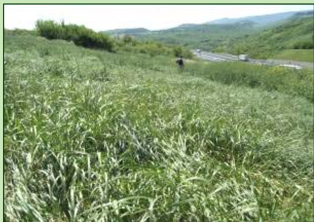
Autostrada A1 MI- NA Impianto di PRATI ARMATI® autoctoni
