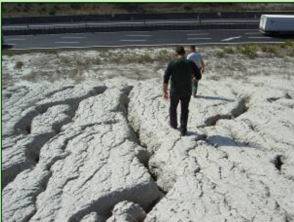
EROSIONE - Autostrada A1 MI-NA, zona Fabro (TR)
