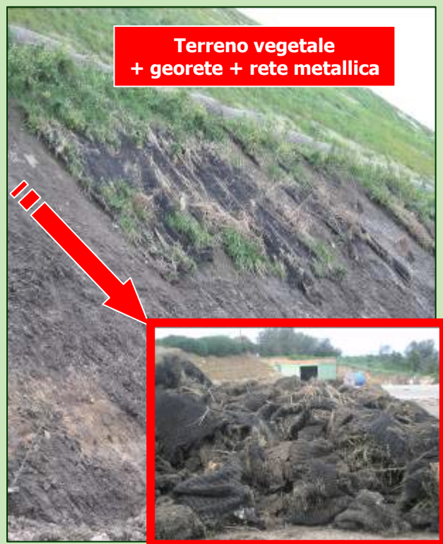
Autostrada in Sicilia: 45° di pendenza. Il terreno vegetale + georete + rete metallica sono collassati dopo piogge intense e prolungate
