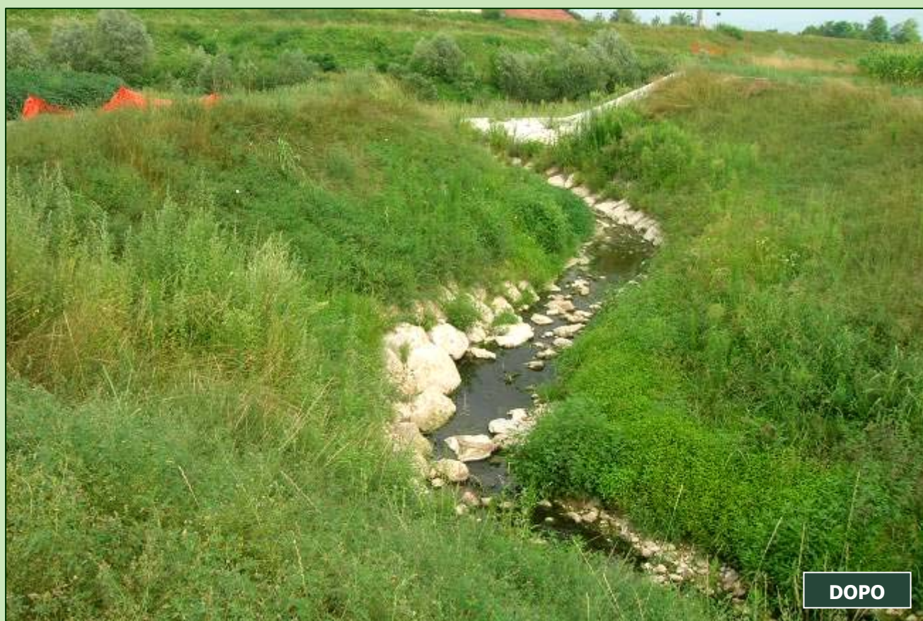
Comune di Pasiano di Pordenone, fiume Meduna - Rivestimento vegetale con i PRATI ARMATI® abbinati a scogliere
