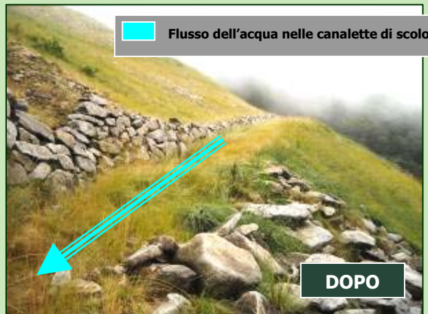
Oropa (BI) - Canalette di scolo realizzate sul terreno tal quale, successivamente inerbite con i PRATI ARMATI® che riducono la velocità di ruscellamento
