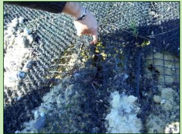
Autostrada A3 SA-RC - Georeti
