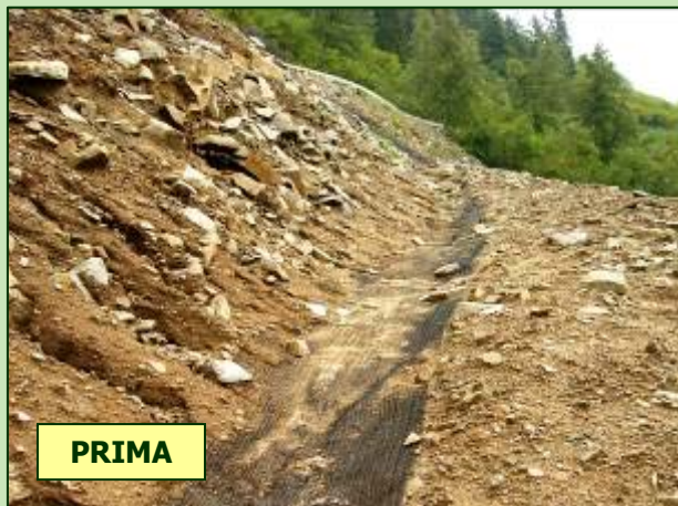
Oropa (BI) - Canalette di scolo realizzate sul terreno tal quale, successivamente inerbite con i PRATI ARMATI® che riducono la velocità di ruscellamento
