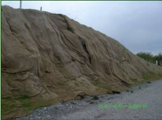
Grecia – Impianto antierosivo su scarpata autostradale realizzato con geostuoie
