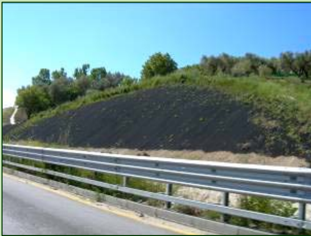
Autostrada A3 SA-RC - Georeti
