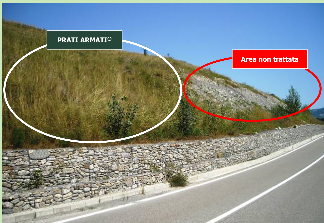
Corniglio (PR), Strada dei Cento Laghi
