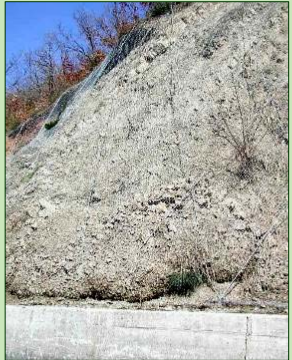
Formazione di sacche di materiale eroso, deformazione e distacco della rete paramassi
