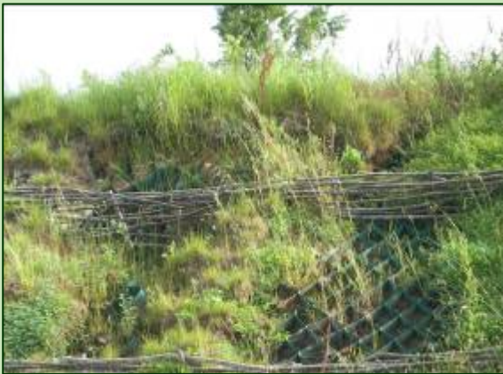
Sicignano (SA) - Impianto antierosivo realizzato con geocelle che possono chiudersi "a fisarmonica" non riuscendo più ad esplicare la loro azione antierosiva
