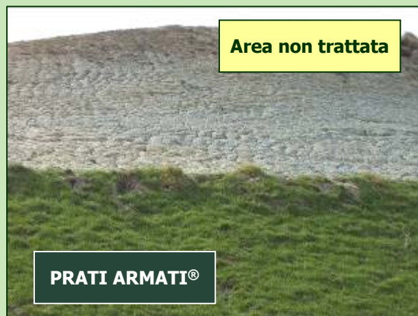
Val d'Agri, SS 92 - Cantiere ANAS
