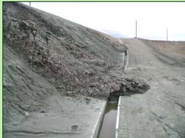
Colata di terra dovuta ad una eccessiva pendenza del versante e ad una erronea captazione delle acque che hanno provocato un forte imbibimento del terreno argilloso
