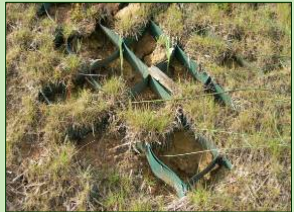
Sicignano (SA) - Impianto antierosivo realizzato con geocelle che possono chiudersi "a fisarmonica" non riuscendo più ad esplicare la loro azione antierosiva
