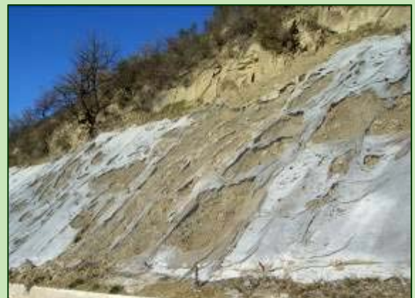
Campobasso - Impianto antierosivo con geotessuto.
