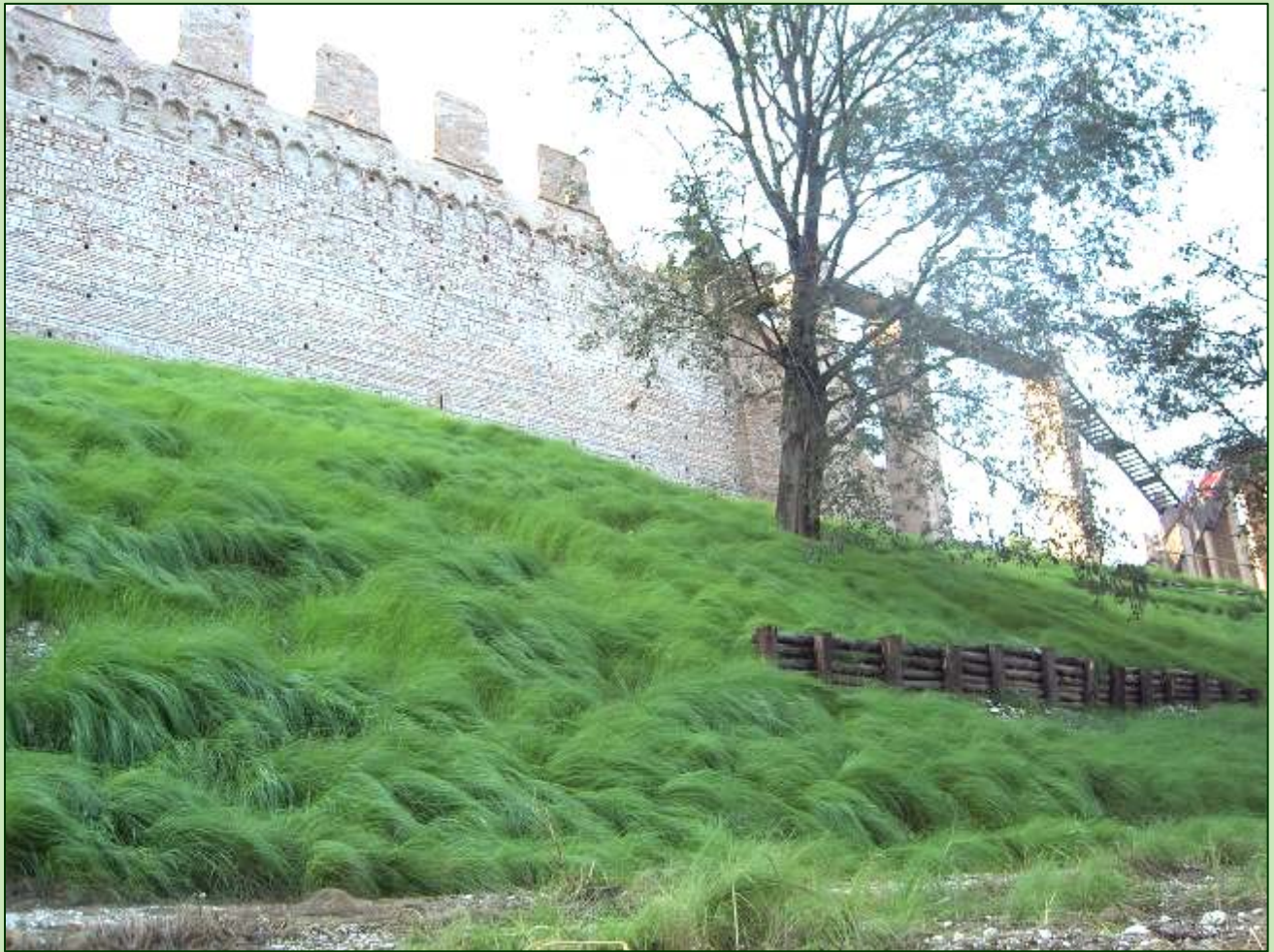
Cittadella (PD) - L'impianto di PRATI ARMATI® non necessita di sfalci
