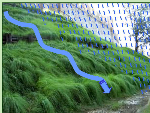
Ruscellamento dell'acqua meteorica dovuta a eventi piovosi intensi al di sopra della coltre erbacea allettata
