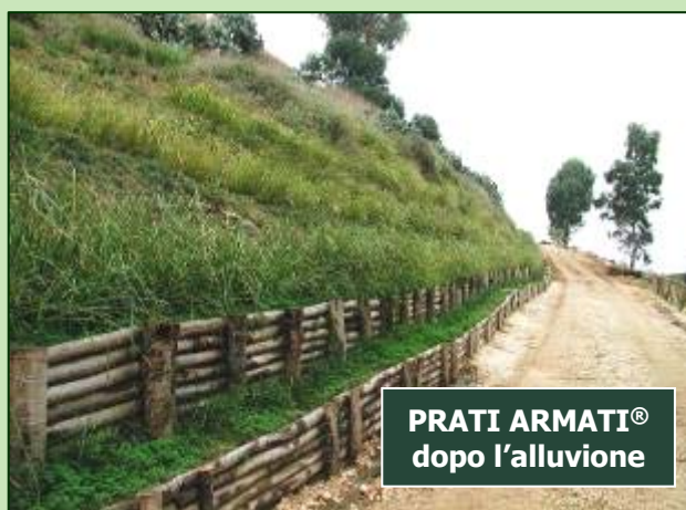
Bernalda (MT) - L'impianto di PRATI ARMATI® ha resistito a un'alluvione
