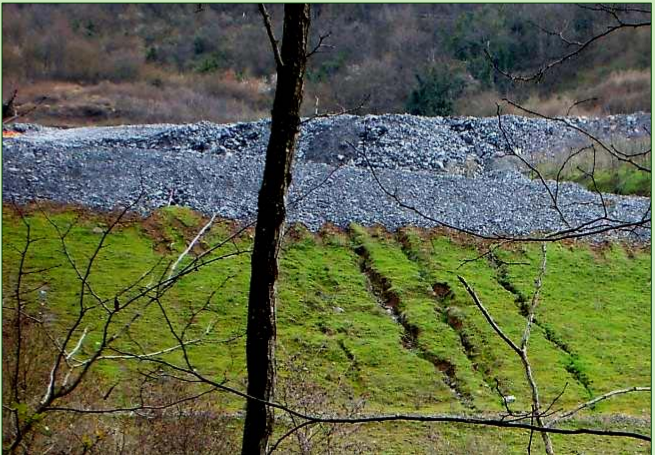
Danni causati dalla presenza di terreno vegetale sugli smarini in un intervento di idrosemina tradizionale
