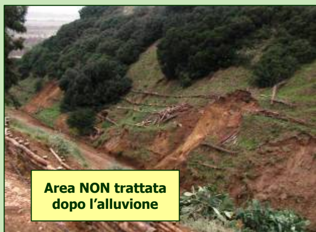
Bernalda (MT) - Crollo delle palizzate nell'area non trattata con PRATI ARMATI®
