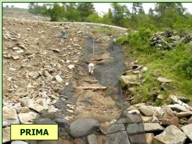
Oropa (BI) - Realizzazione di collettori di scolo autoadattanti
