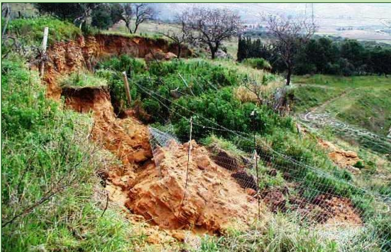
Esempi di pendii con evidenti problemi di instabilità ( F_s < 1 ) non risolvibili dai soli PRATI ARMATI®
