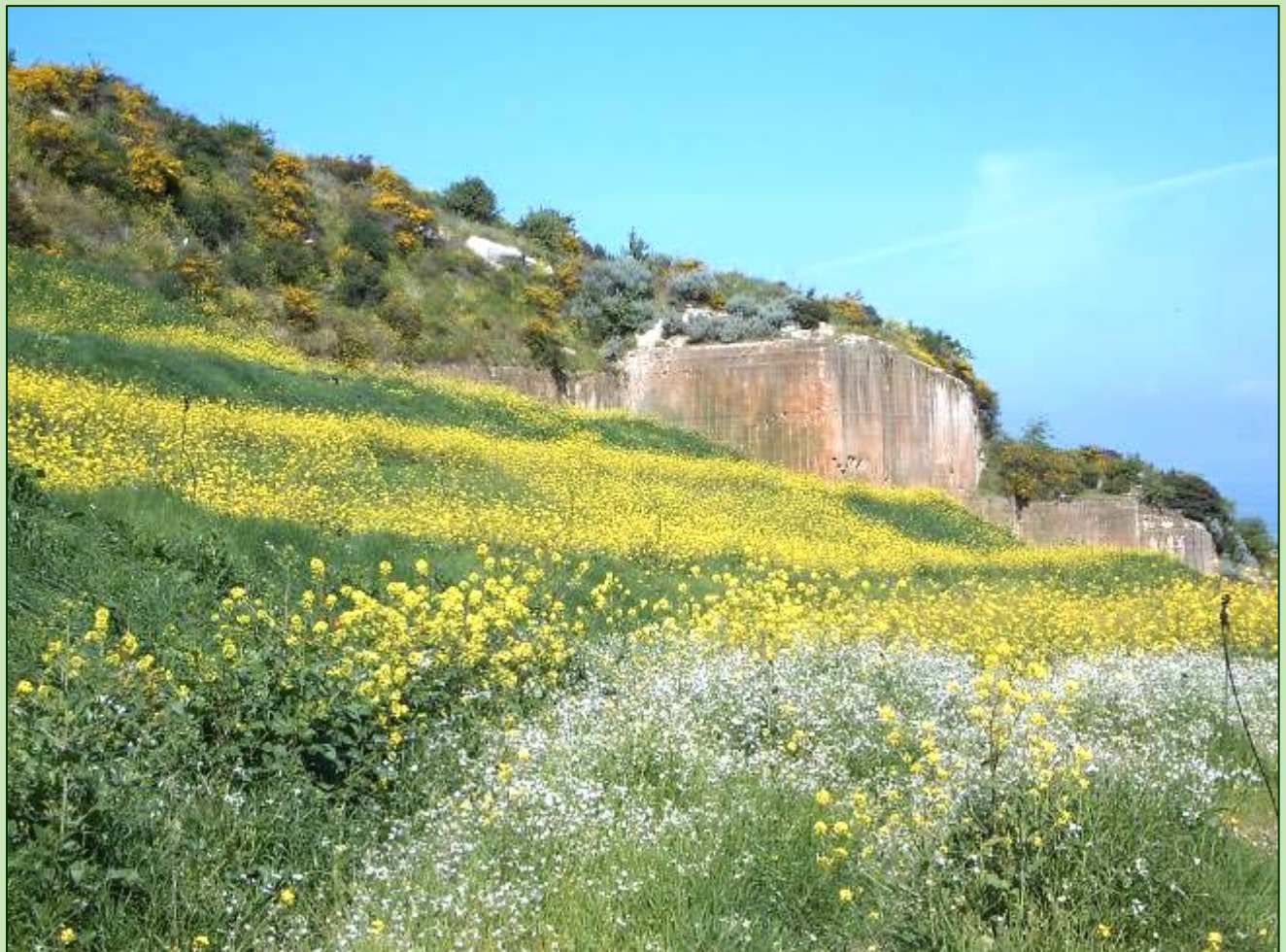
Discarica di Ozieri (SS) - Impianto di PRATI ARMATI® autoctoni integrato con sementi fiorifere locali
