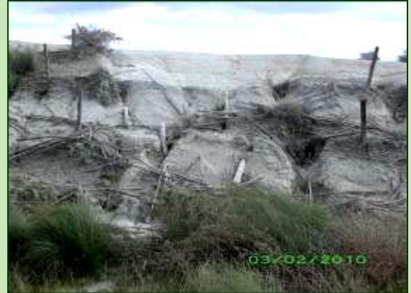
SS 106 Jonica – Impianto antierosivo realizzato con fascinate
