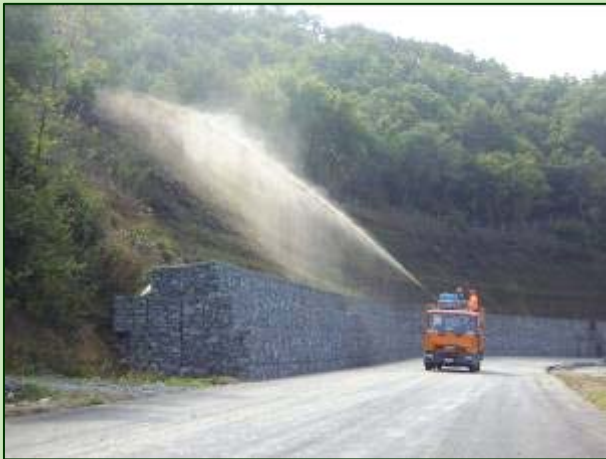
Idrosemina con mezzo gommato
