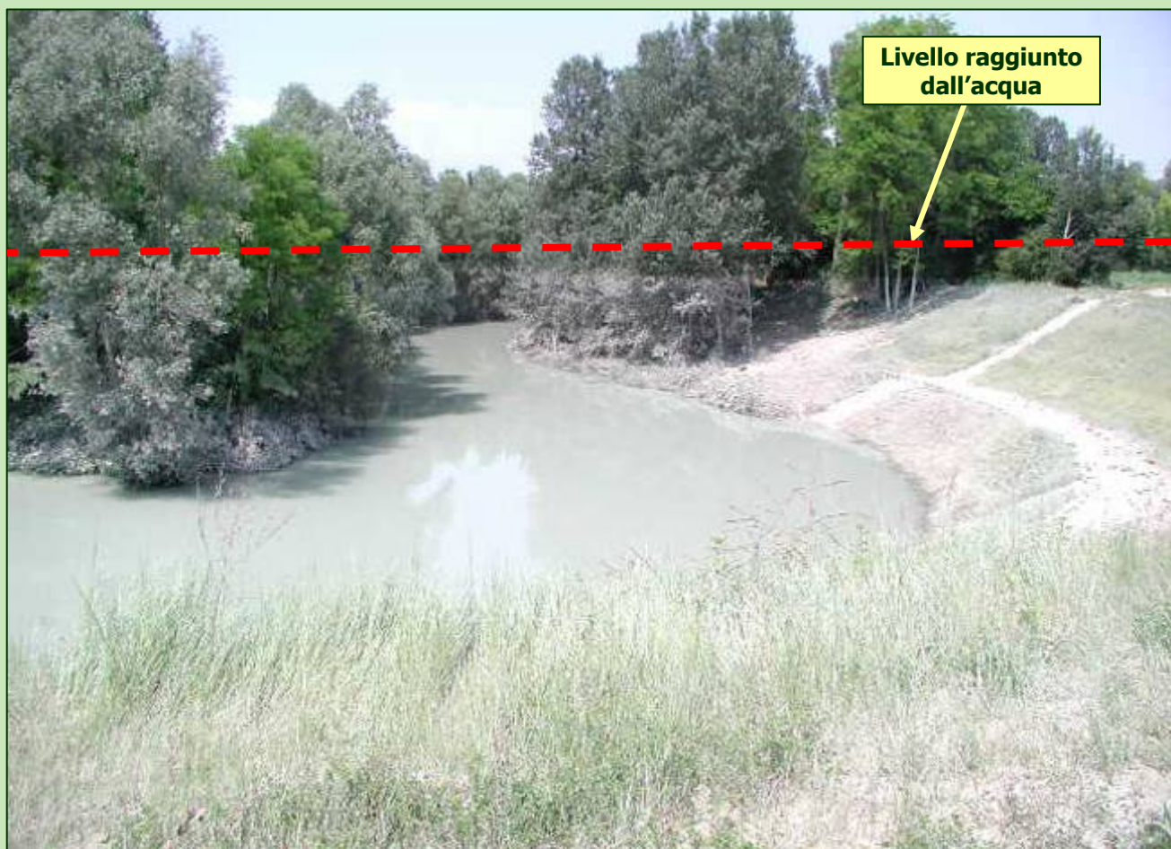
Pordenone, fiume Noncello, alluvione del 2002 - L'impianto ha resistito alla sommersione durata molti giorni
