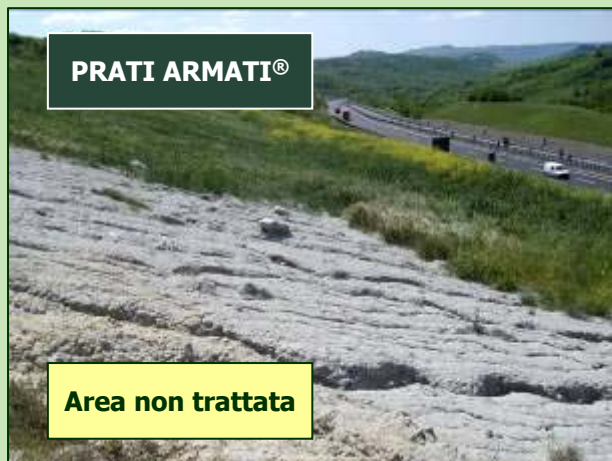
Fabro (TR) - Autostrada A1 MI-NA
