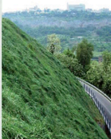
La scarpata consolidata e rinverdita a maggio 2006
