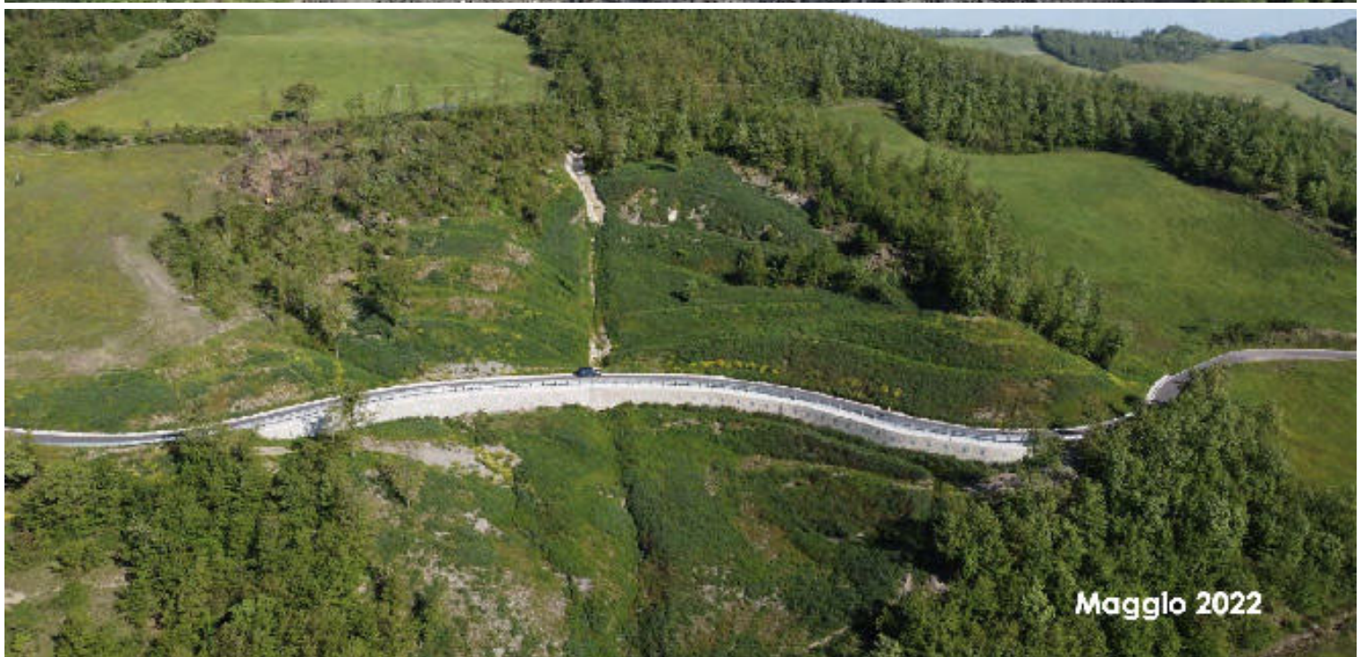
Immagine sopra (giugno 2021): vista del cantiere prima dell'impianto con i Prati Armati. Evidente il dissesto erosivo e idraulico. Immagine sotto (maggio 2022): vista del cantiere dopo i Prati Armati.
