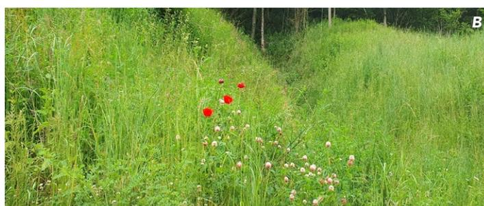
**4A e 4B.** Opere di regimazione idraulica e captazione delle acque meteoriche e superficiali realizzate con i soli Prati Armati® che hanno retto a eventi meteorici di particolare intensità senza produrre erosione e rallentando l'acqua grazie alla folta coltre epigea elastica e resistente. Nessuna manutenzione è stata mai fatta su queste opere idrauliche e non sarà mai più necessaria con forti risparmi di costi e rischi di cantiere
