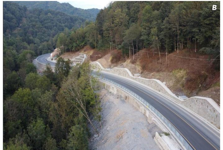
**2A e 2B.** A sinistra riempimento della parte a valle della strada con smarino estratto dalla galleria. A destra parte del rilevato colmato da smarino e il detrito di versante sterile a monte dell'infrastruttura. Su entrambi si sono realizzate canalette sul tal quale inerbite poi con i Prati Armati®
