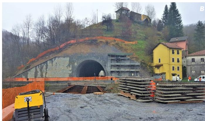
**1A e 1B.** Le ostili condizioni climatiche e pedologiche del cantiere prima dell'intervento con i Prati Armati®, fonte di dissesti superficiali, colamenti, rilasci di materiali ed erosione. La parte a monte è un detrito eterometrico, la parte a valle è costituita da smarino derivante dallo scavo delle gallerie
