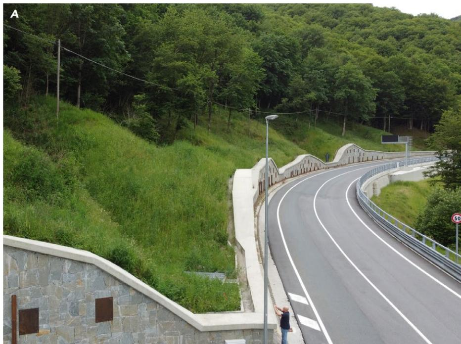
**3A e 3B.** I risultati geotecnici superficiali e idraulici ottenuti con l'intervento dei Prati Armati®. Viste delle scarpate a monte e a valle dell'infrastruttura e delle opere idrauliche e di regimazione delle acque tutte realizzate in un'unica soluzione sul tal quale
