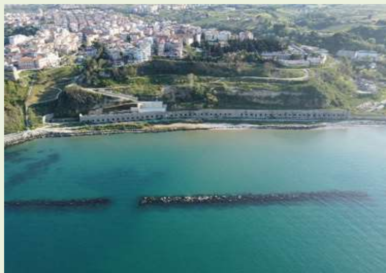
Il cantiere di Ortona realizzato con i Prati Armati®
