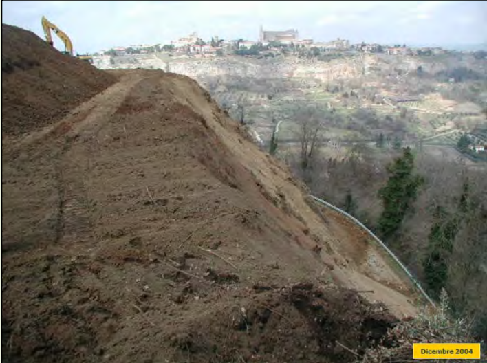
L'impressionante parete in depositi piroclastici disgregati e affioramenti basaltici con pendenze fino a 80°
