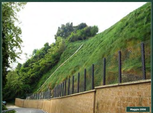
I PRATI ARMATI® hanno ormai ricoperto tutto il versante mascherando anche le reti metalliche
