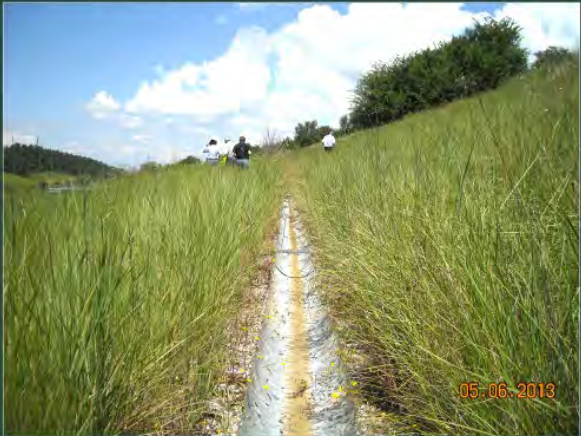
I pendii protetti dai PRATI ARMATI® non hanno mostrato segni di erosione: le canalette sono perfettamente pulite e non intasate dal materiale eroso
