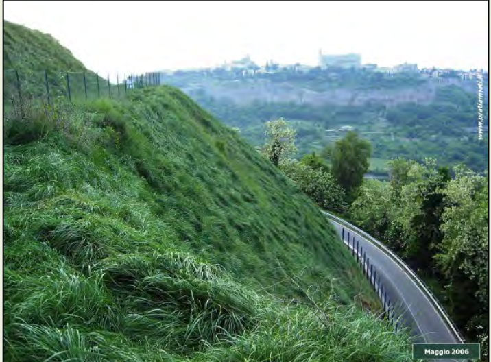
I PRATI ARMATI® hanno ormai ricoperto tutto il versante mascherando anche le reti metalliche
