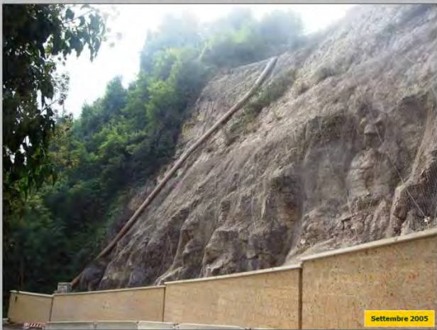
L'impressionante parete in depositi piroclastici disgregati e affioramenti basaltici con pendenze fino a 80°
