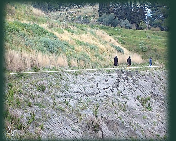
Cava di Menfi-AG. Argille. Sopra zona trattata con piante erbacee a radicazione profonda. Sotto senza alcun trattamento.
