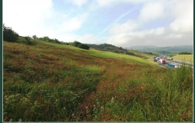
DOPO L'ALLUVIONE DI NOVEMBRE 2012 NESSUNA EROSIONE O CEDIMENTO
