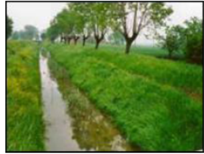
Pavia Böschung eines Bewässerungskanals
