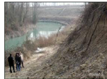
Detailblick der nicht-befestigten und von dem Erdbeben befallenen Zone mit ausgerissenen Bäumen und Zurücksetzen des Ufers um mehr als 10 Meter
