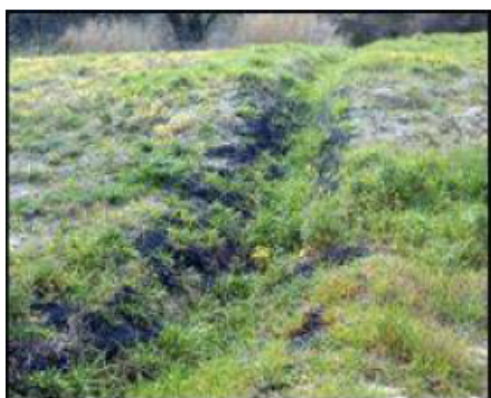
Kanal mit Plastikgeonetz und traditioneller Hydrosaart
