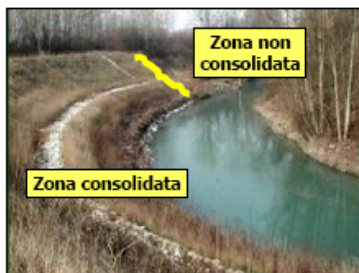
Detailblick der nicht-befestigten und von dem Erdbeben befallenen Zone mit ausgerissenen Bäumen und Zurücksetzen des Ufers um mehr als 10 Meter
