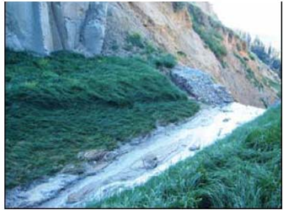
Die Anlage befestigt und begrünt im Mai 2007. Die Pflanzen liegen alle in Richtung des Stromes nach einem Hochwasser
