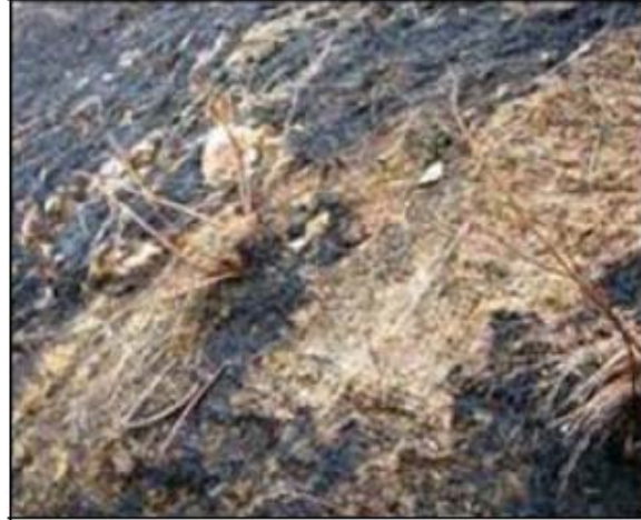
Geonetze und traditionelle Hydrosaat nach einem Brand
