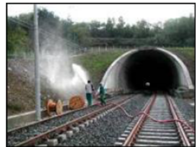
Eisenbahnböschung Italferr – Aulla (MS)
