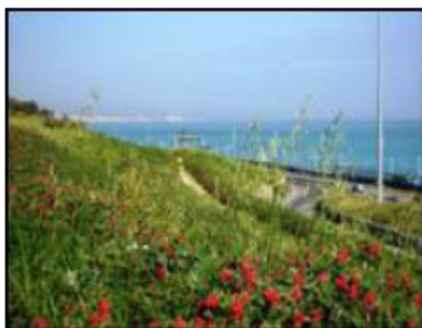
Großer Erdbeben in Ancona Straßenböschung
