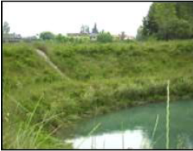
Flussufer Noncello Staatliches Bauamt di Pordenone
