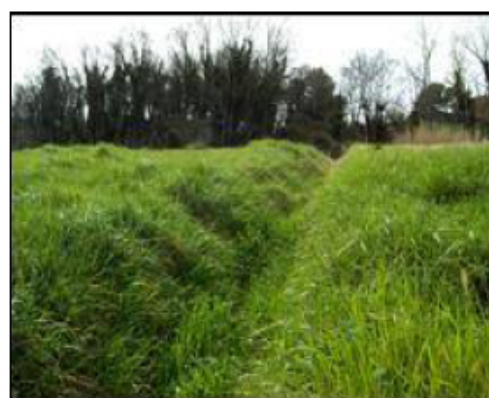
Kanal mit Plastikgeonetz kombiniert mit der Befestigung von PRATI ARMATI®
