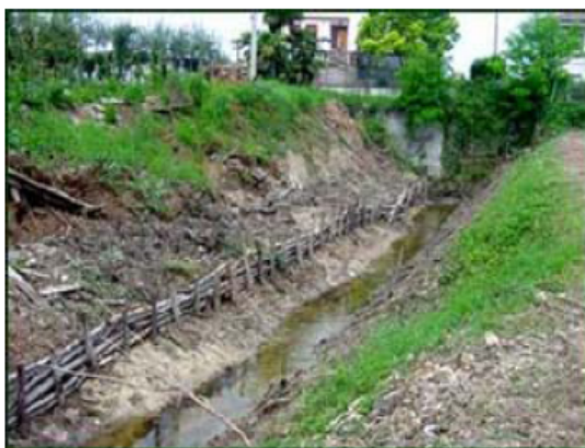
Oktober 2001: Kanalufer zusammengebrochen nach einem Hochwasser in der Provinz von Brescia.
