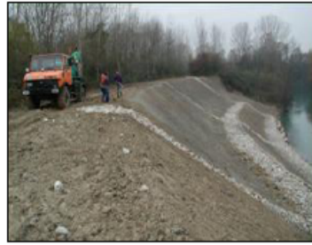
Hydrosaat auf dem erneut behandelten und vorbereiteten Ort
