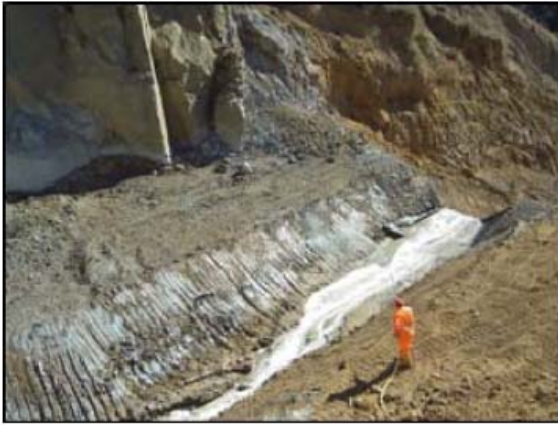
November 2006: Hydrosaat von PRATI ARMATI kombiniert mit Böschungsmauern in der Provinz von Matera
