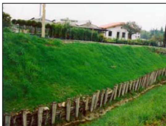
Anlage befestigt mit PRATI ARMATI im Mai 2002
