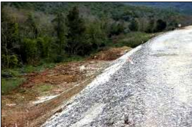
Toscana. Le remblai réalisé en matériel aride en gros morceaux avant l'intervention
