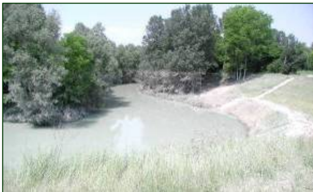
Nord Italie - Pordenone, fleuve Noncello - inondation du 2002 L'implantation à résistée à la submersion durée plusieurs jours. A noter sur les arbres le limon déposé indice du niveau atteint par l'eau
