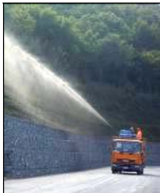
Hydro-semilles en domaines facilement accessibles
