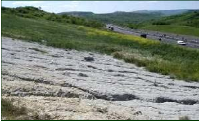
Centre Italie - Fabro (Terni) - Autoroute A1 Milan-Naples, est évidente la nette séparation entre le domaine avec semilles PRATI ARMATI® et celui non traité
