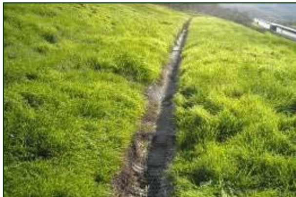
Après le traitement avec PRATI ARMATI® l'érosion est bloquée et le matériel éros n'engorge plus les caniveaux : ont été annules les couts de manutention
