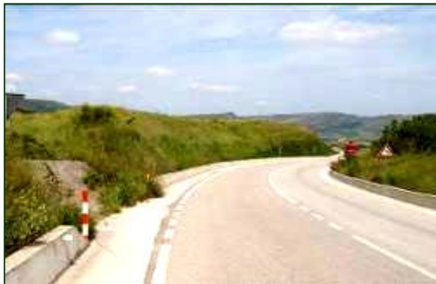
Repousse après l'incendie
