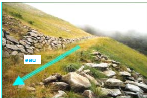
Les caniveaux de drainage réalisés sur le sol tel quel et enherbés avec PRATI ARMATI® qui réduisent la vitesse de ruissellement du sol
