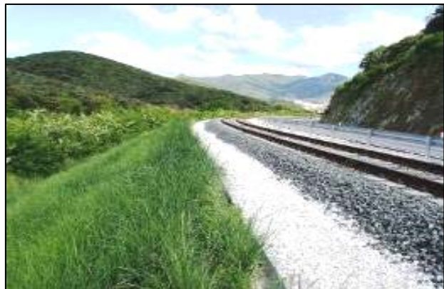
Toscana. Les remblais ferroviaires (50.000 mètres carrés) après l'intervention avec les PRATI ARMATI® POUR REMBLAIS
