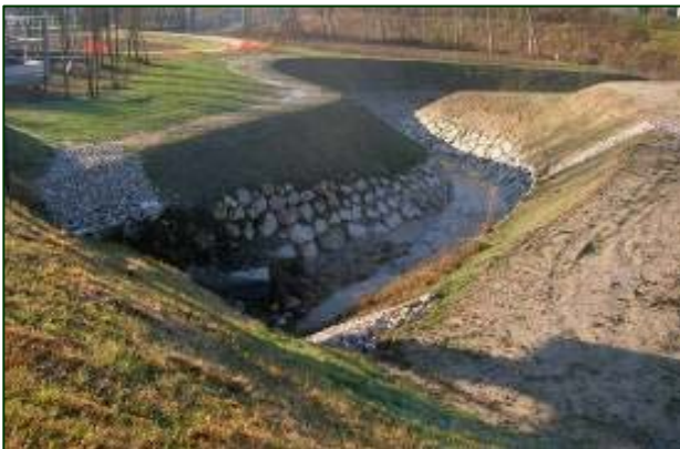
Nord Italie - Pasiano di Pordenone, fleuve Meduna – Protection des berges réalisée avec falaise
