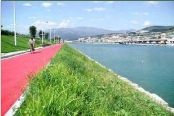
Nord Italie - Genova Voltri, implantation avec plantes herbacée à radication profonde au bord de la mer
