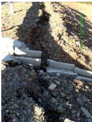
Affaissement de caniveaux réalisés avec nouettes sur remblais routières
