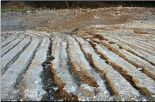
La forte érosion sur le terrain végétal sur les remblais
