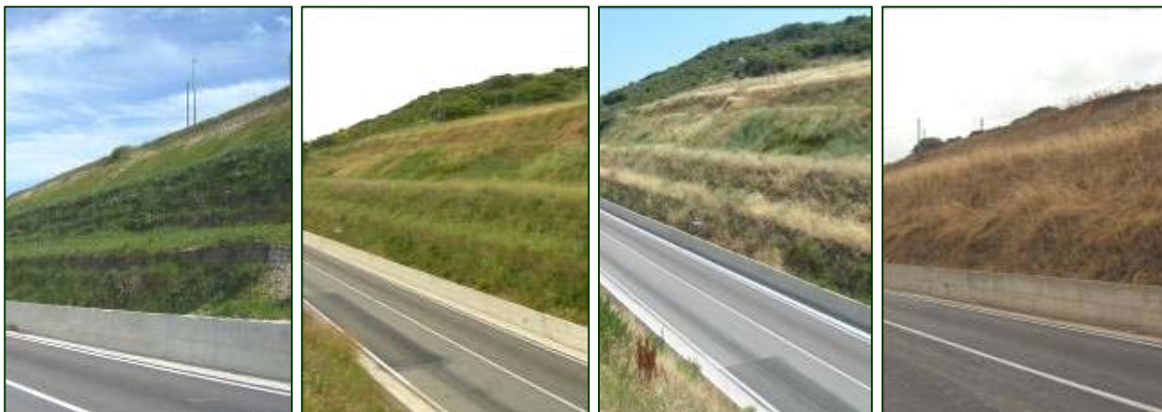
Sardaigne - Escarpements routières à Florinas (Sassari) - Aspect des PRATI ARMATI® et des plantes locales pendant les différentes saisons
