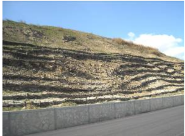
Collapse d'une implantation antiérosive réalisée avec clayonnage (treillis de bouture se saules).
