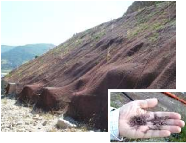
Géogrilles après 2 années de la mise en œuvre, dégradées par les agents atmosphériques
