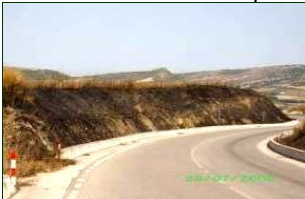
Sardaigne - Florinas-Muros (Sassari) – PRATI ARMATI® après un incendie
