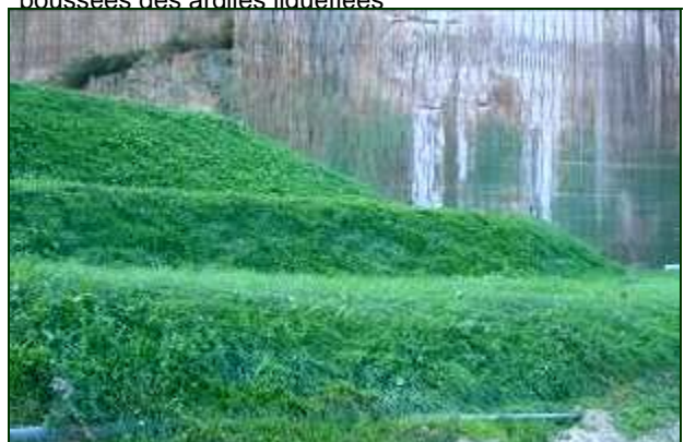
Le système terrain-racines déformées résiste aux poussées des argiles liquéfiées
