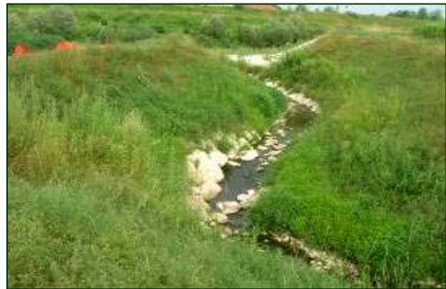
Nord Italie - Pasiano di Pordenone, fleuve Meduna - Protection des berges réalisée avec PRATI ARMATI® en combinaison avec falaises
