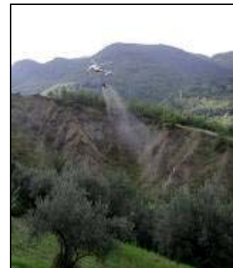
Hydro-semilles avec hélicoptères en domaines non accessibles
