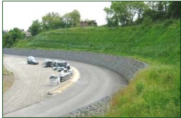
Centre Italie - Castelviscardo (Terni), nouvelle périphérique. Gabions protégés amont par des plantes herbacées à radication profonde
