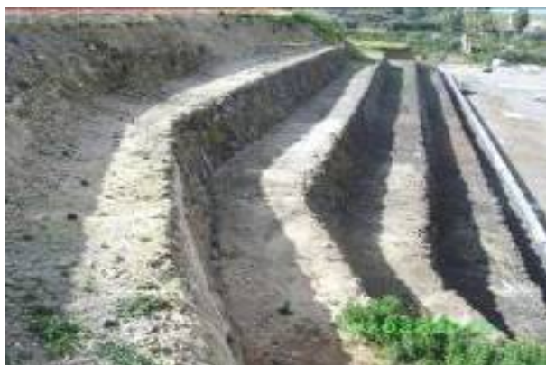
Sicile – Escarpement sujet à érosion et de forte impact sur environnement
