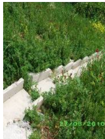
Caniveaux réalisés avec nouettes sur remblais protégés par plantes herbacées à radication profonde
