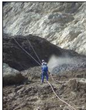
Hydro-semilles avec tuyaux et grimpeurs
