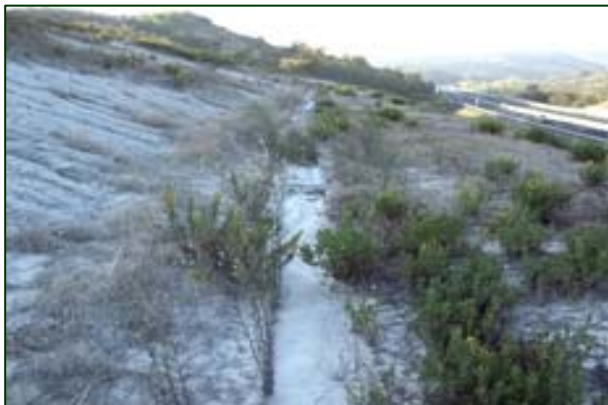
Autoroute A1 Milan-Naples. Les caniveaux s'engorgent en continuation et se rend nécessaire une manutention continue pour les maintenir propres et efficients
