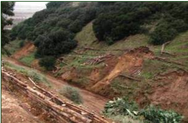
Sud Italie - Bernalda (Matera) – Effondrement des palissades en domaine non traités après l'inondation
