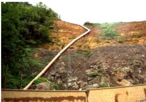
Orvieto (TR) – L'escarpement protégé par filets de protection, était sujet à forte érosion
