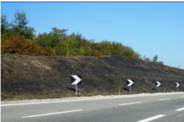
Autoroute A6 TO-SV- Les vieux géogrilles restées sombres pendant 15 années
