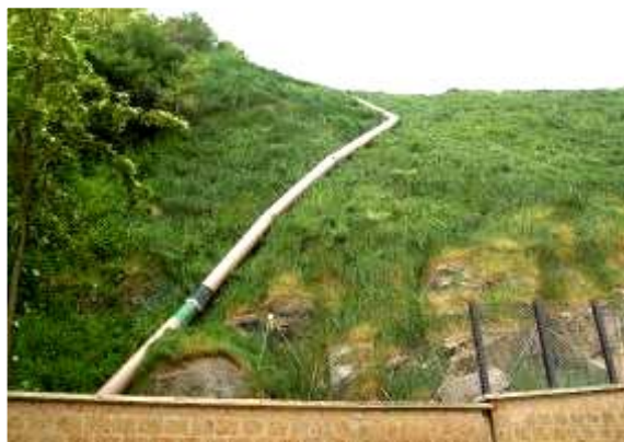
Orvieto (TR) – après le traitement avec PRATI ARMATI®. L'érosion a été bloquée et le domaine est ré-naturalisé. Les filets de protection sont camouflés et protégés du déchaussement. Les plantes herbacées à radication profonde, avec leur racines, encrent le filet au sol.
