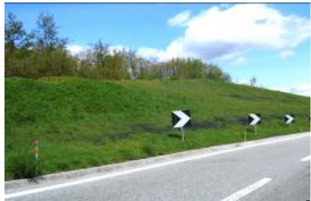
Autoroute A6 TO-SV, intervention avec PRATI ARMATI®: l'érosion a été bloquée, l'escarpement à ré-naturalisée et les géogrilles noires ont été masquées par une épaisse couverture végétale
