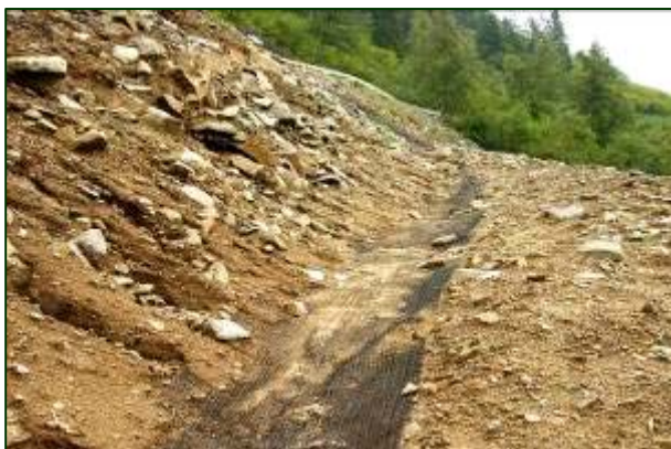
Nord Italie - Oropa (Biella) – Caniveaux de drainage réalisés sur le sol tel quel
