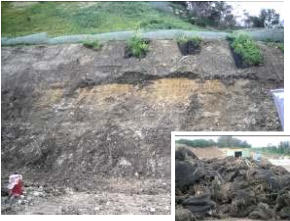
Collapse d'une implantation antiérosive réalisée avec terrain végétal + géogrilles + hydro-semilles traditionnelle + fils métalliques + fixation au moyen de piquets profonds
