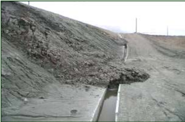
Coulée de terre due à une excessive inclination du versant et une erronée réglementation des eaux qui ont provoqué une forte imbibition du terrain argileux
