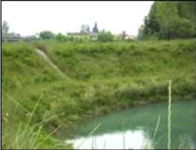
Berge du fleuve Noncello Génie Civile de Pordenone
