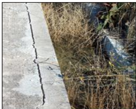
Ancona – canal engorgé dans la zone non traitée avec les PRATI ARMATI®
