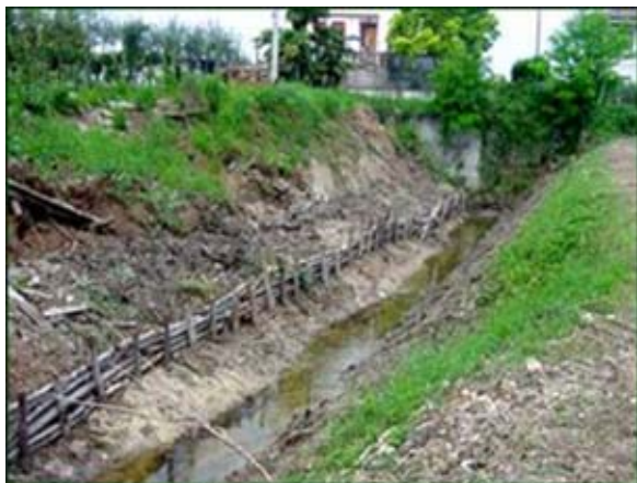
Octobre 2001: bergée d'un canal éboulé après une inondation auprès de Brescia
