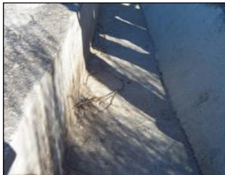
Canal parfaitement propre dans la zone protégée par les PRATI ARMATI®
