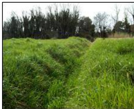
Canal avec géogrille en plastique et PRATI ARMATI®
