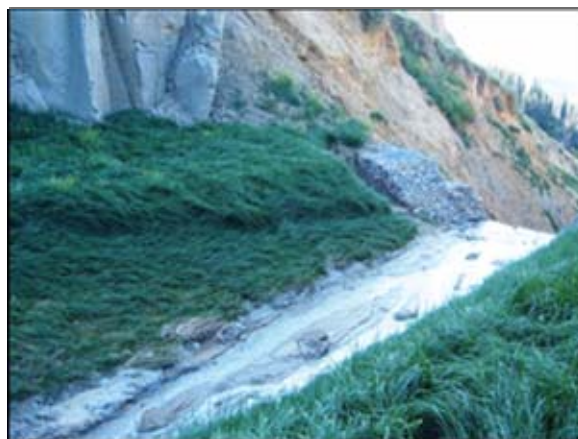
Le site renforcé et reverdi en Mai 2007. La végétation est pliée selon le courant après une inondation
