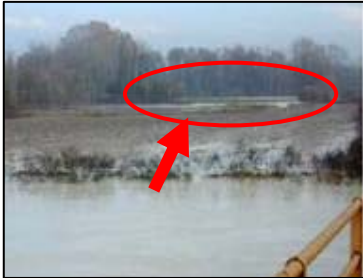
Le chantier sous l'inondation du Nov. 2002
