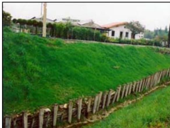
Le site renforcé avec les PRATI ARMATI en Mai 2002
