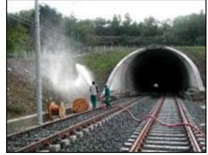
Escarpement ferroviaire Italferr – Aulla (MS)
