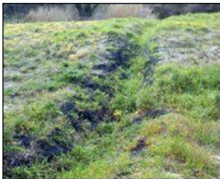
Canal avec géogrille en plastique et hydro-semailles traditionnelle
