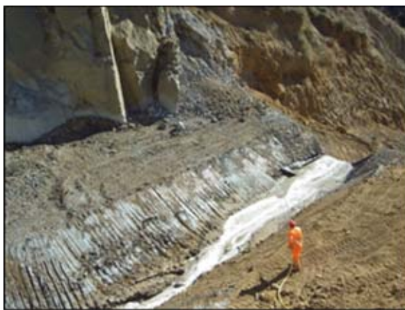
Novembre 2006: hydro-semailles de PRATI ARMATI accouplées à des ouvrages de renforcement hydrologiques (seuils) dans l'Italie du Sud
