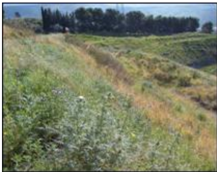
Sciaccia (AG): consolidation et rénaturalisation d'une cave d'argile
