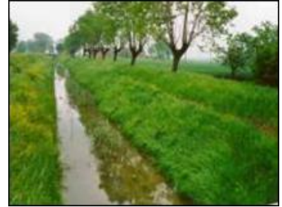
Berge d'un canal d'irrigation - Pavia
