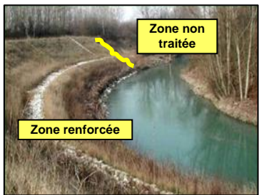
Particuliers de la zone non renforcée et éboulis, avec des arbres déracinés et glissement du berge de plus de 10 mètres
