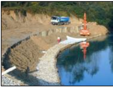
Les travaux sur les berges
