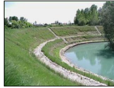
L'ouvrage après 1 an environs
