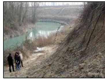
Particuliers de la zone non renforcée et éboulis, avec des arbres déracinés et glissement du berge de plus de 10 mètres
