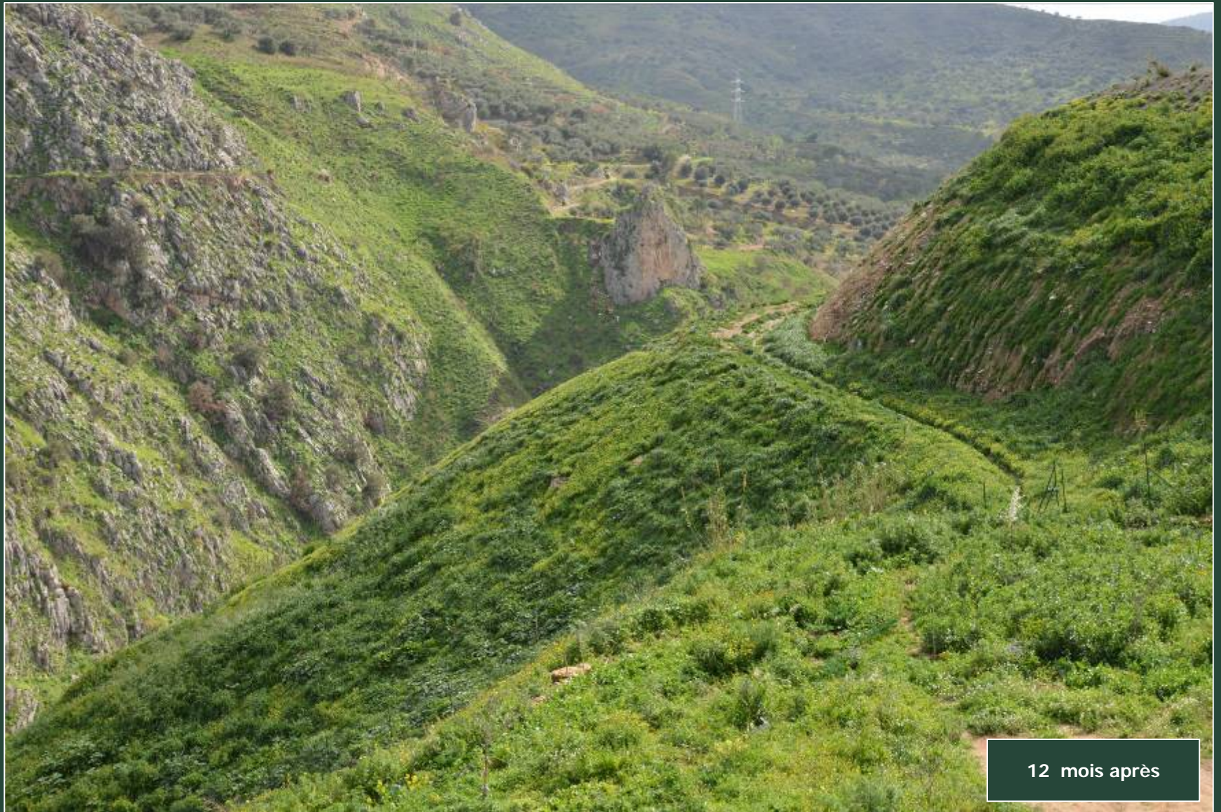
L'excellente enherbement de la décharge environ 12 mois après l'intervention d'hydro-semailles
