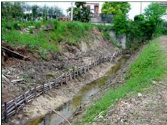
*Octubre de 2001: orilla de un canal derrumbada en ocasión de una riada en provincia de Brescia*
