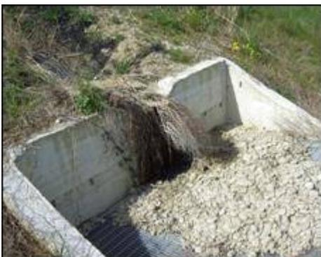
Canal con geored en plástico combinado con armazón vegetal "prati armati"
