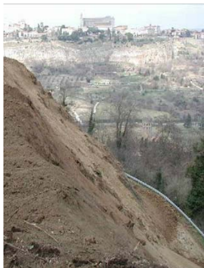
Piroclastiti tufacee alterate e basalti intensamente fratturati prima e dopo l'intervento antierosivo con PRATI ARMATI®
