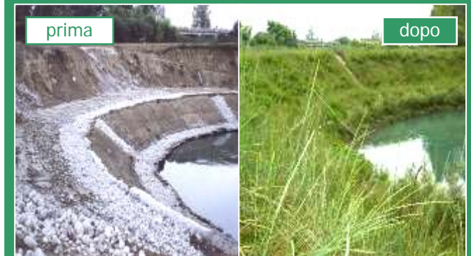
Regione Friuli: protezioni spondali
