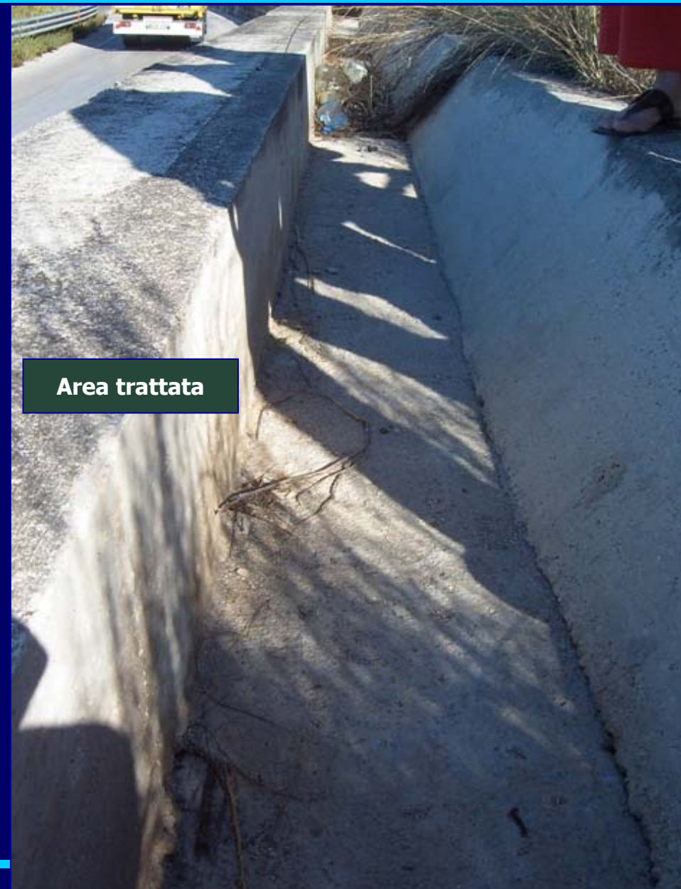
Ancona bypass - Area trattata
