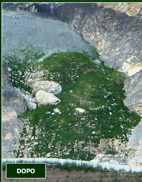
TRENTO Discarica Ischia Podetti blocco dell'erosione e rinaturalizzazione di un detrito di falda carbonatico
