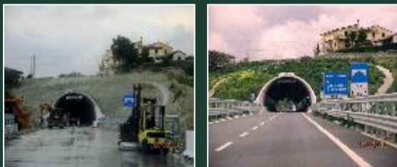
ANAS: SS 106 Jonica Marina di Gioiosa Jonica Cantiere su smarino tal quale
