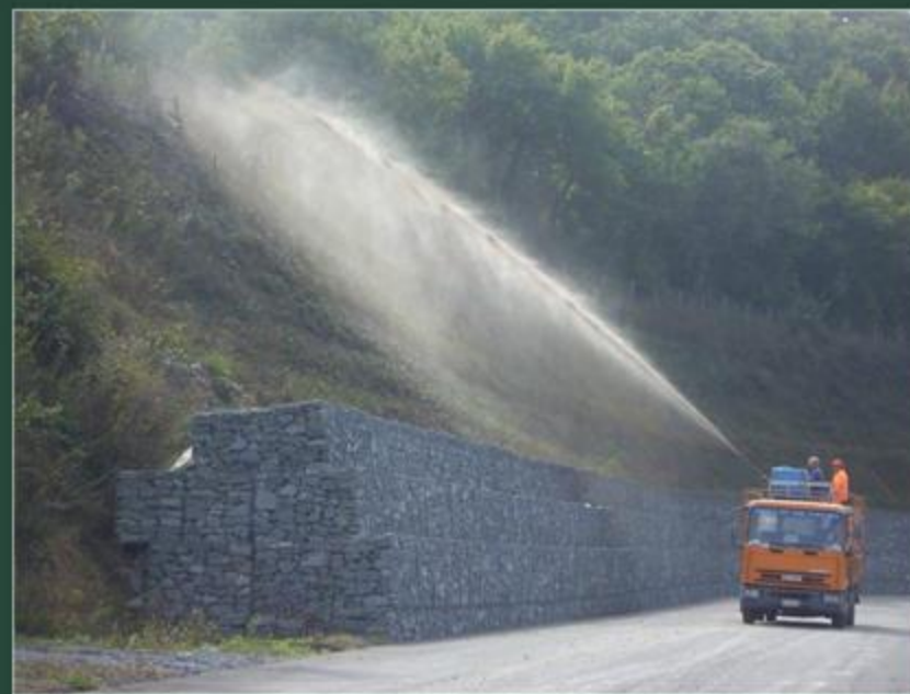
Castelviscardò (Terni): Idrosemina con macchina idroseminatrice montata su mezzo gommato
