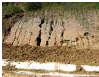
» Figg. 166, 167 Protezione di scarpate dall'erosione con erbe a radicamento profondo prima e dopo inerbimento
