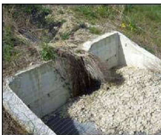
Canal cu geogrilile din plastic și hidrosemințe tradiționale
