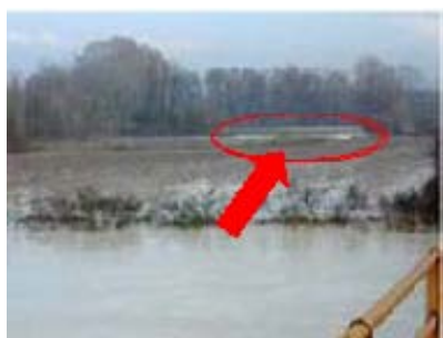
Un șantier inundat în nov. 2002
