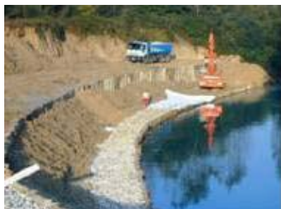
Realizarea lucrărilor pe mal
