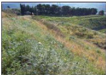
Sciacca (AG): consolidarea și renaturalizarea unei ravenă de argilă
