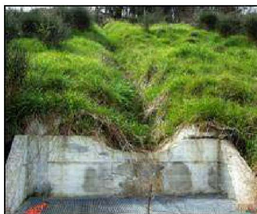
Canal cu geogrilile din și PRATI ARMATI®
