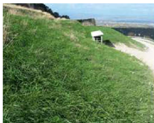
Depozit de deșeuri urbane la Ozieri (SS)
