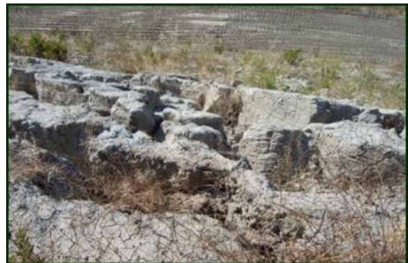
Figura 9: Esempio di deformazioni irreversibili del versante
