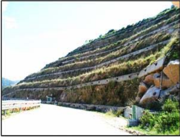
Figura 14: Il cantiere di Orgosolo ad aprile 2013, prima dell'alluvione
