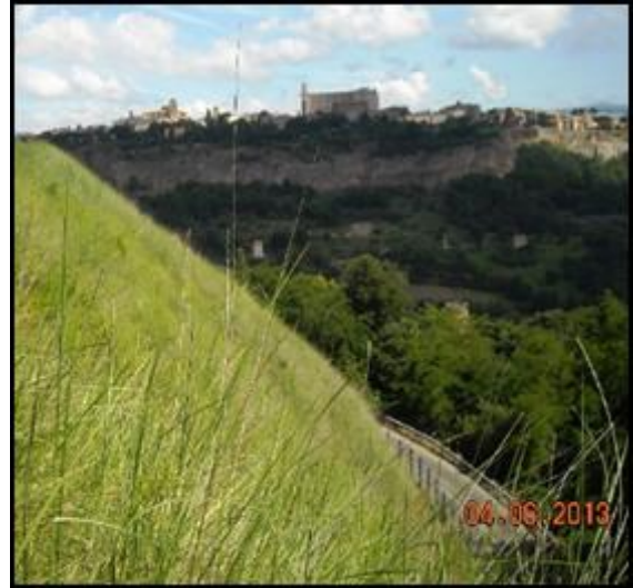
Figura 12: Cantiere di Orvieto in perfette condizioni dopo l'alluvione di novembre 2012
