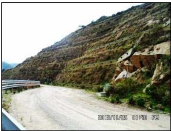
Figura 15: Il cantiere di Orgosolo in perfette condizioni dopo l'alluvione del novembre 2013
