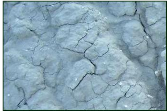
Figura 8: Crepacciamento delle argille in assenza di copertura vegetale
