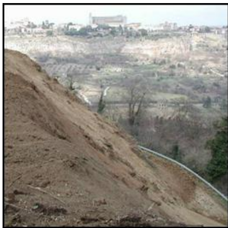
Figura 10: Cantiere di Orvieto prima dell'intervento (2005)
