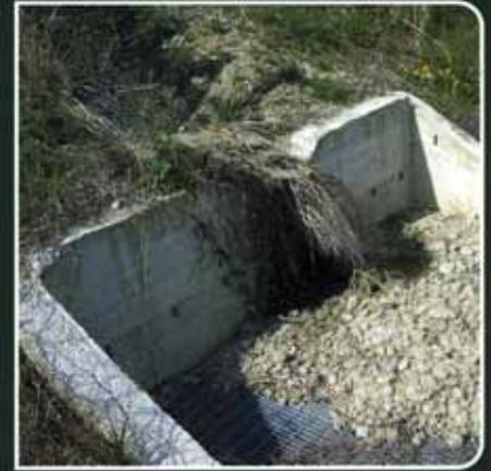
L'erosione provoca l'intasamento delle opere di captazione e regimentazione delle acque: fossi di guardia, canalette, pozzetti di raccolta, e così via. Le opere di captazione intasate diventano inefficienti e favoriscono l'infiltrazione di acqua nei versanti, causa di instabilità e cedimenti anche profondi. È quindi necessaria una continua manutenzione per svuotare le canalette intasate da fango e detriti, con elevati costi e rischi.
