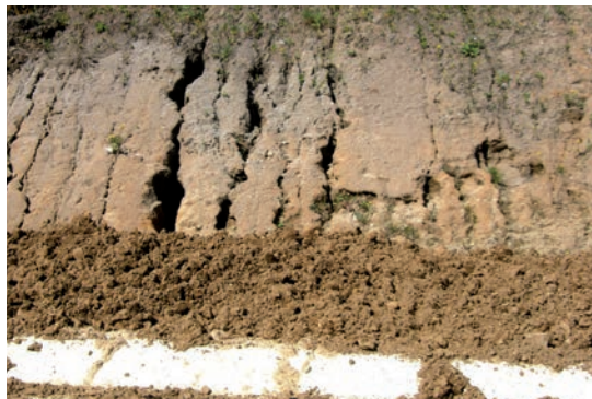
Autostrada A3 Salerno – Reggio Calabria, zona Palmi (RC). Il sito prima e dopo l'intervento con i PRATI ARMATI®. Litotipo: sabbie limose
