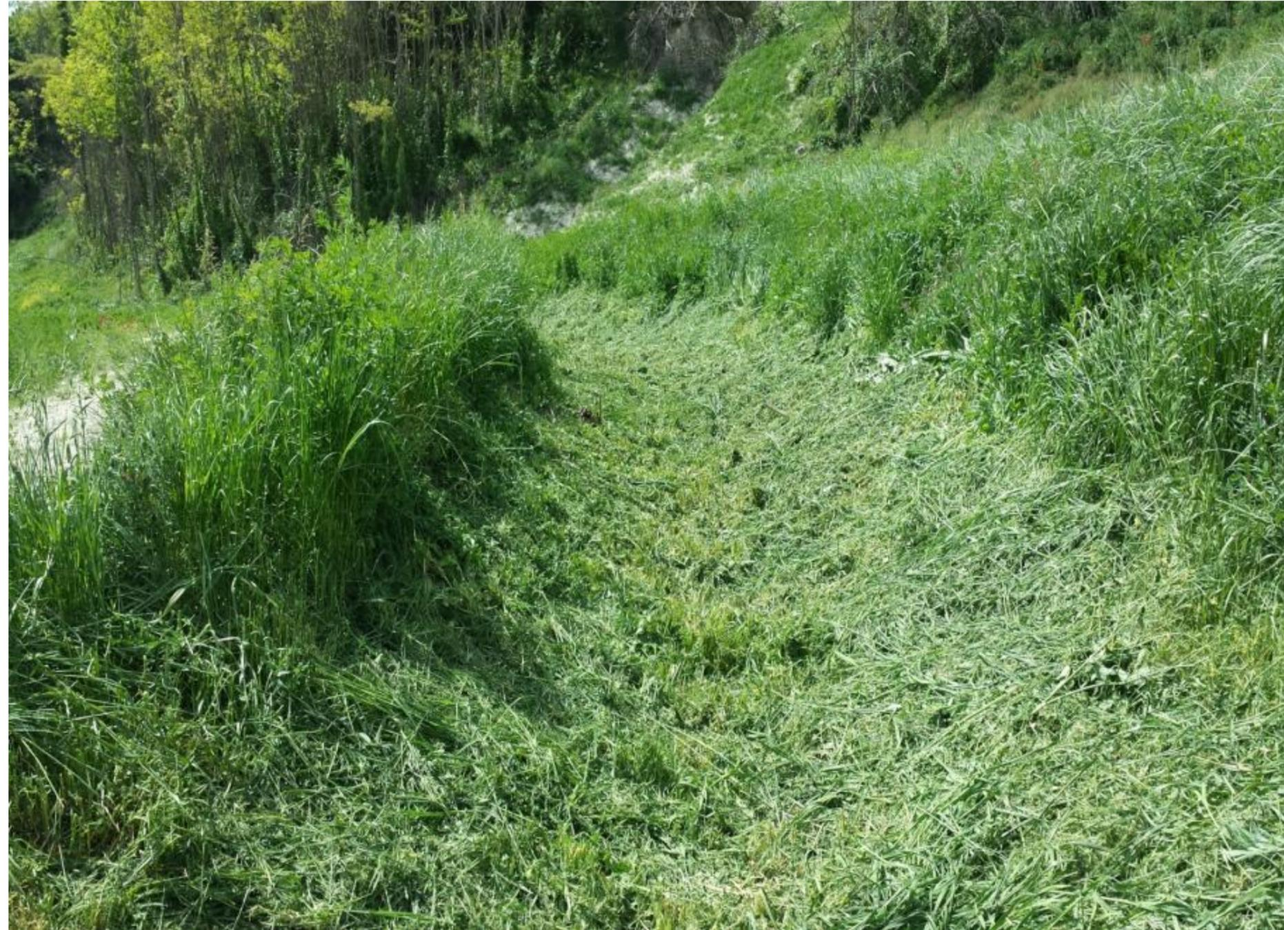
Inerbimento con semina di PRATI ARMATI® del fondo e delle pareti delle canalette, con funzione antiersiva e per rallentare ulteriormente la velocità dell'acqua
