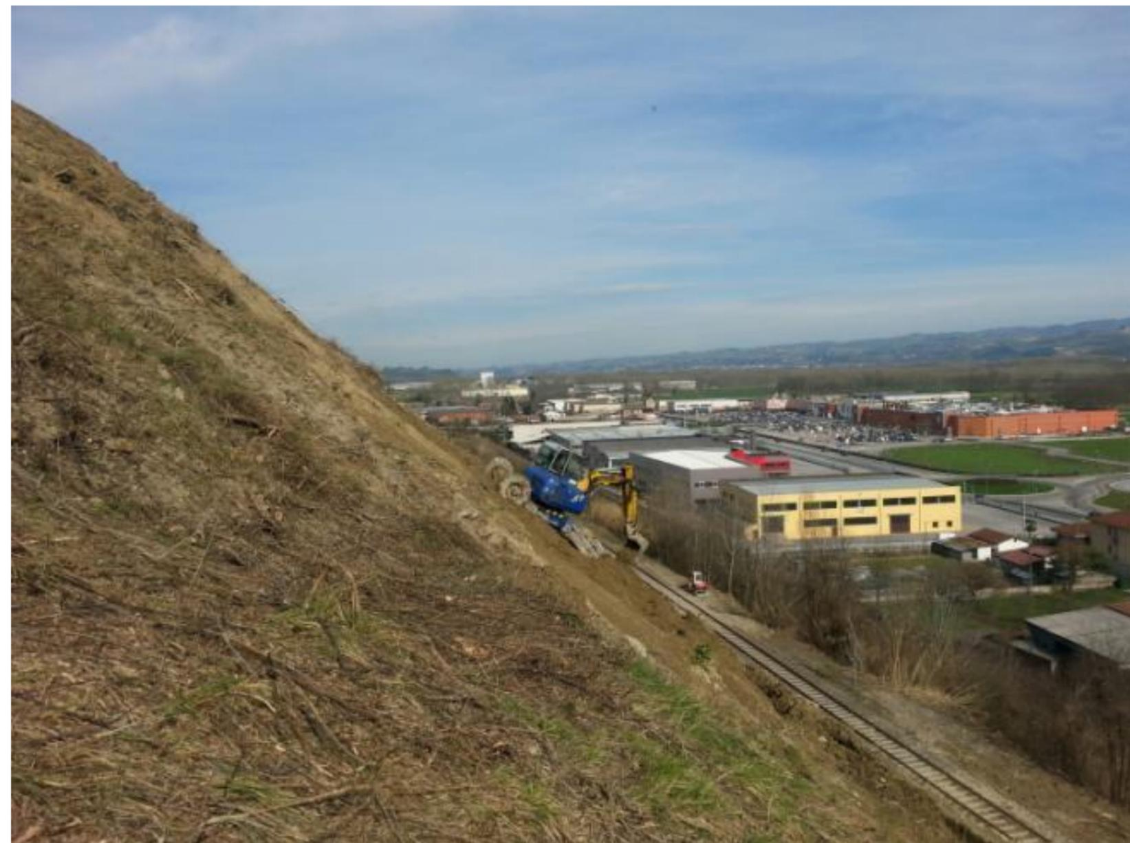
Disgaggio dello strato corticale instabile
