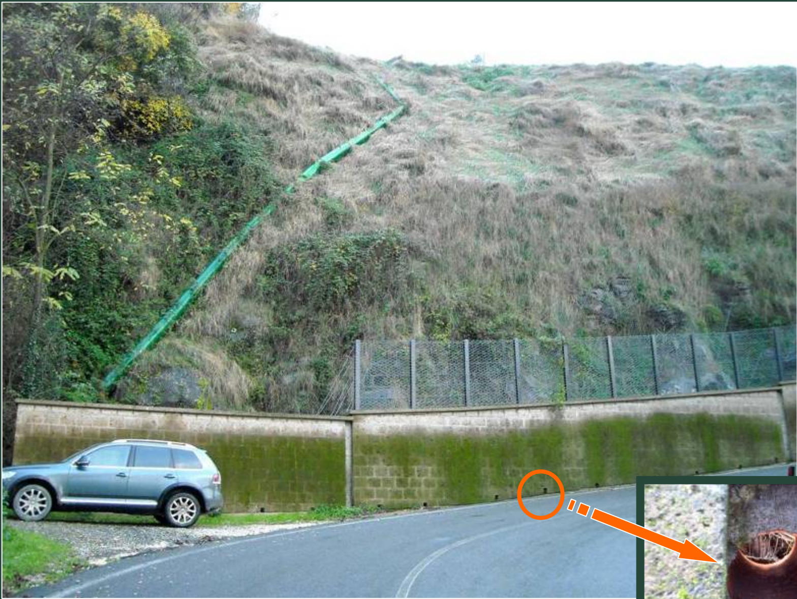
Orvieto (TR) - Coltre vegetale allettata dopo gli intensi eventi piovosi del 28 novembre 2009. I barbacani sono perfettamente puliti nonostante a monte ci sia una parete rocciosa alta circa 30 m
