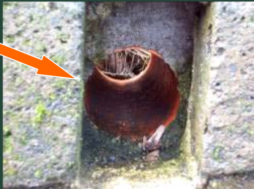
Orvieto (TR) - Coltre vegetale allettata dopo gli intensi eventi piovosi del 28 novembre 2009. I barbacani sono perfettamente puliti nonostante a monte ci sia una parete rocciosa alta circa 30 m
